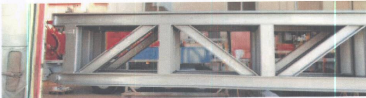
Fig. 8 - Carpenteria sgrassata e preparata al grado Sa2,5
